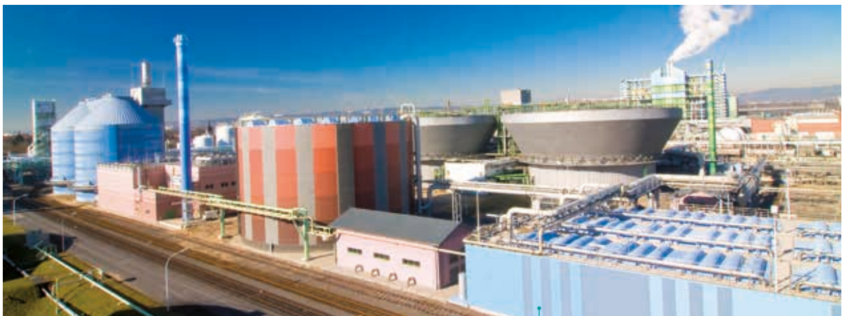
Die Biogasanlage im Industriepark Höchst. (Foto: InfraserV GmbH & Co. Höchst KG, 2017)
