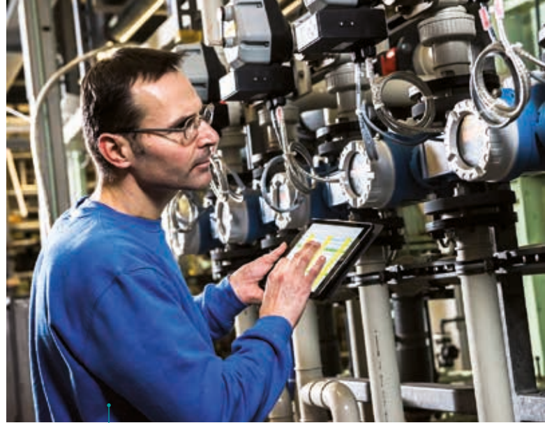
Optimierte Abwasserbehandlung in einem Betrieb der Lebensmittelindustrie. (Foto: EnviroChemie)
