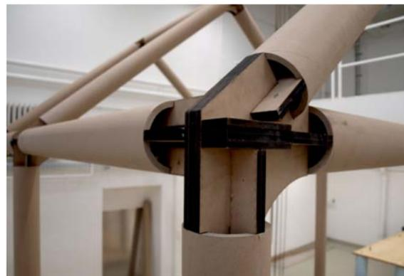
Knotenkonstruktion zur Verbindung von Papierhülsen für Rahmenstrukturen
