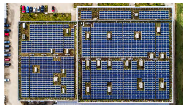
Photovoltaik im gewerblichen Bereich: Ungenutzte Dachflächen – wie etwa hier auf einem Industriegebäude in Tettmang – bieten ein riesiges Potenzial für die dezentrale und klimafreundliche Energieproduktion. Foto: © SMA Solar Technology
