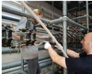
Arbeiten am Technikum. Foto: Kai Ruf
