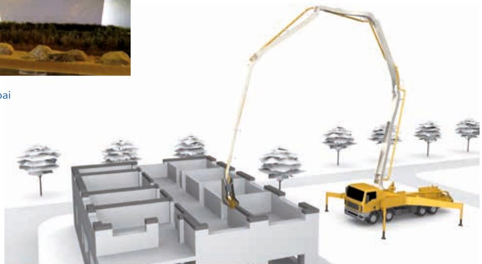
CONPrint 3D - Mit Druckkopf ausgestatteter Großraumroboter (Quelle: TU Dresden)
