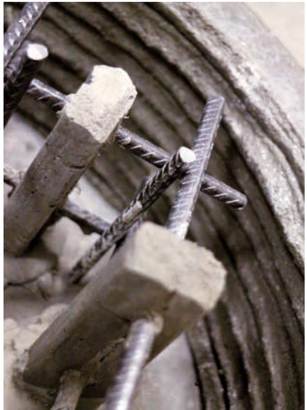
Beton 3D-Druck mit Stahlbewehrung (Quelle: Imprimere)
