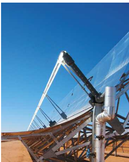
Solarthermisches Kraftwerk (Quelle: Schott)
