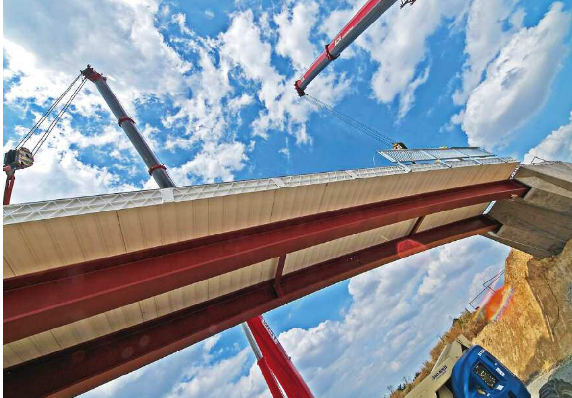
Glasfaserverstärkte Brücke (Quelle: Hessisches Landesamt für Straßen- und Verkehrswesen)
