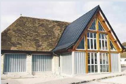
Beispiele lichtdurchlässiger Aerogelfassaden in der Praxisanwendung
