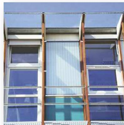
Aufbau durchscheinender Aerogelfassaden und Pilotanwendung in einem Gebäude (Quelle: ZAE Bayern)
