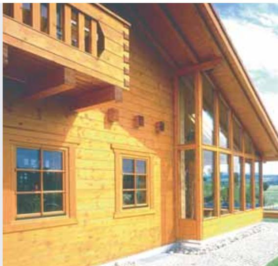
Abb. 1: Holzschutzlasur auf Basis von transparentem Eisenoxid (Quelle: Akzo).
