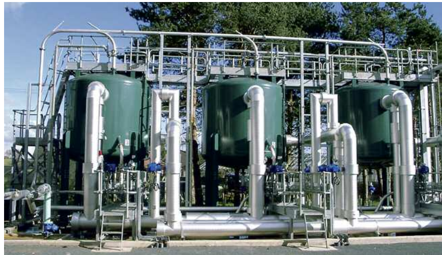
Abbildung 10: Anlage eines Festbettreaktors aus Eisenhydroxidoxid-Granulat Bayoxide® E33 mit sehr fein strukturierten Oberflächen im Nanobereich zur Arsenadsorption (Quelle: Bayer AG, Severn Trents Services)
