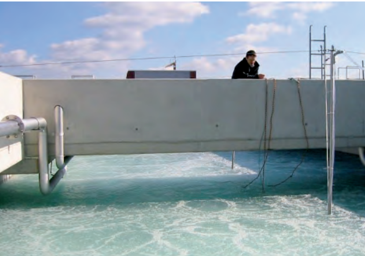
Moderne Abwasserreinigung in der Kläranlage Kassel
