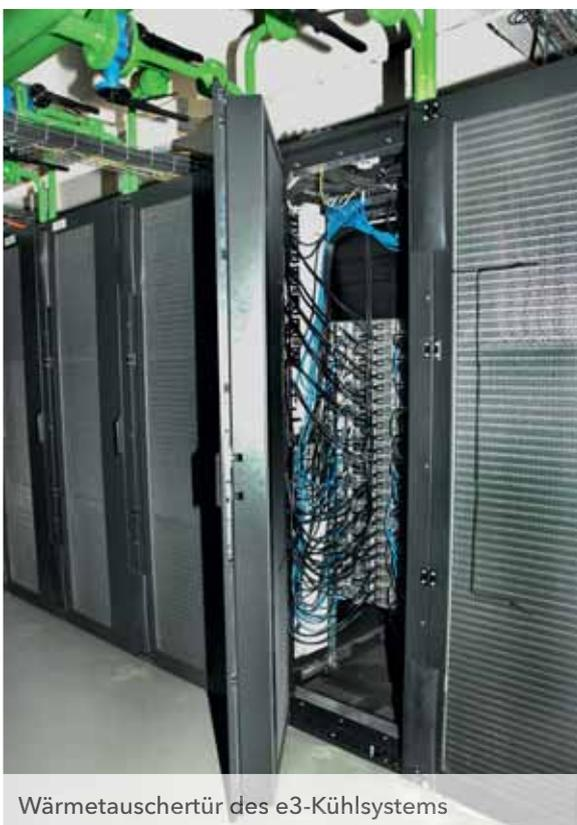
Wärmetauschertür des e3-Kühlsystems
