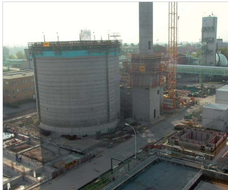
Etwas Großes entsteht im Industriepark Höchst: Der Bau der CO-Fermentationsanlage schreitet zügig voran.
