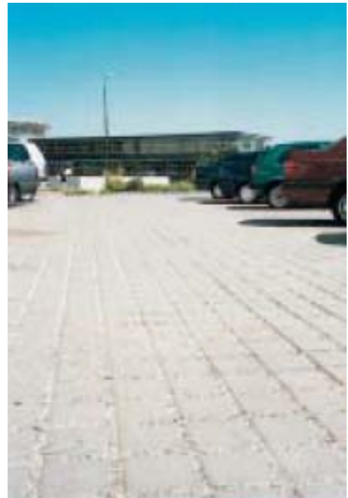
Abb. 2.3.2 Wasserdurchlässige Befestigung Büroparkplatz in Künzell
