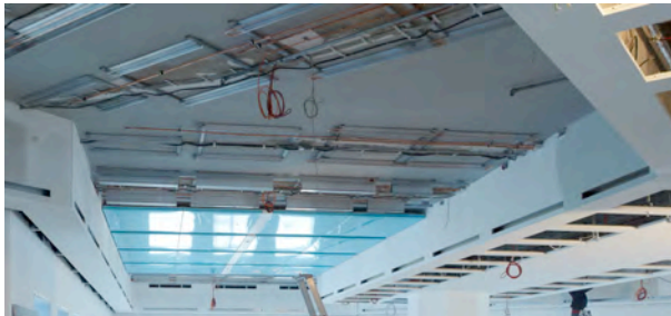
Unterkonstruktion der Heiz-/Kühldecken mit Aktivierungsprofilen
