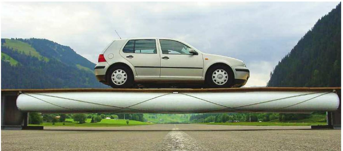
Tensairity® Demonstrations-Brücke mit 8 m Spannweite und 3.5 t max. Last (Quelle: EMPA)
